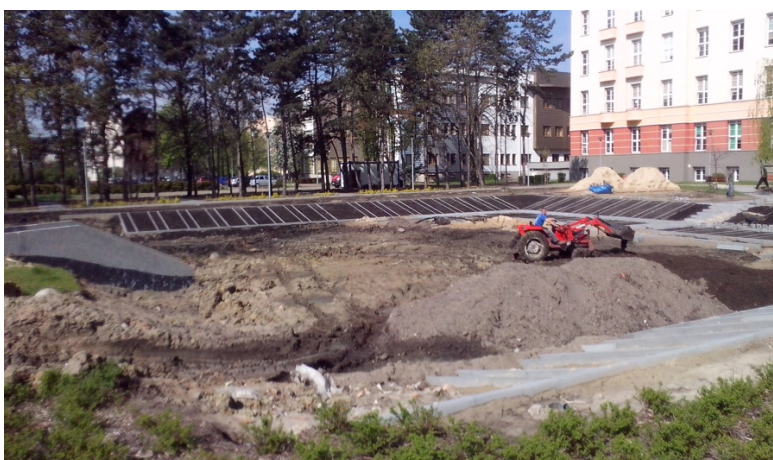
Fot. 5. Prace ziemne, zakładanie kwater, 22.04.2014r.
