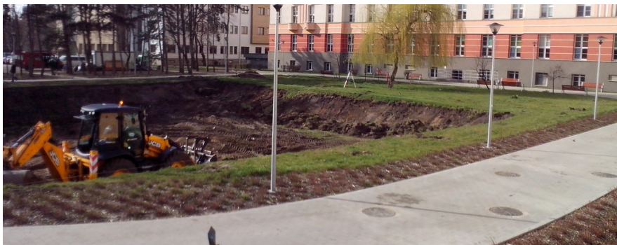
Fot. 4. Początkowe prace ziemne, 26.03.2014r.
