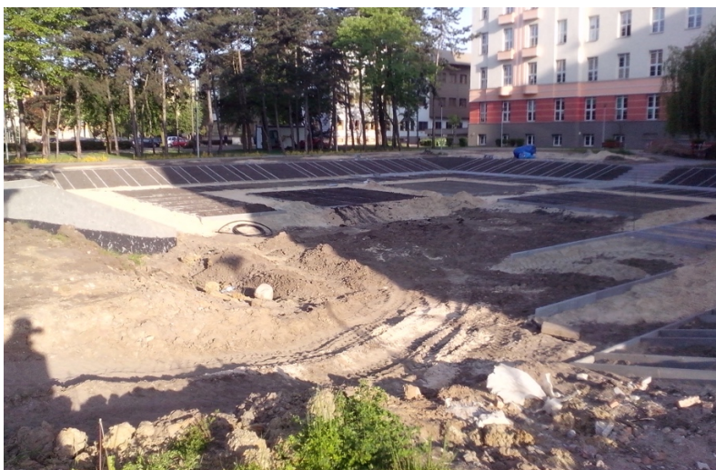
Fot. 6. Prace budowlane i instalacyjne, 06.05.2014r.
