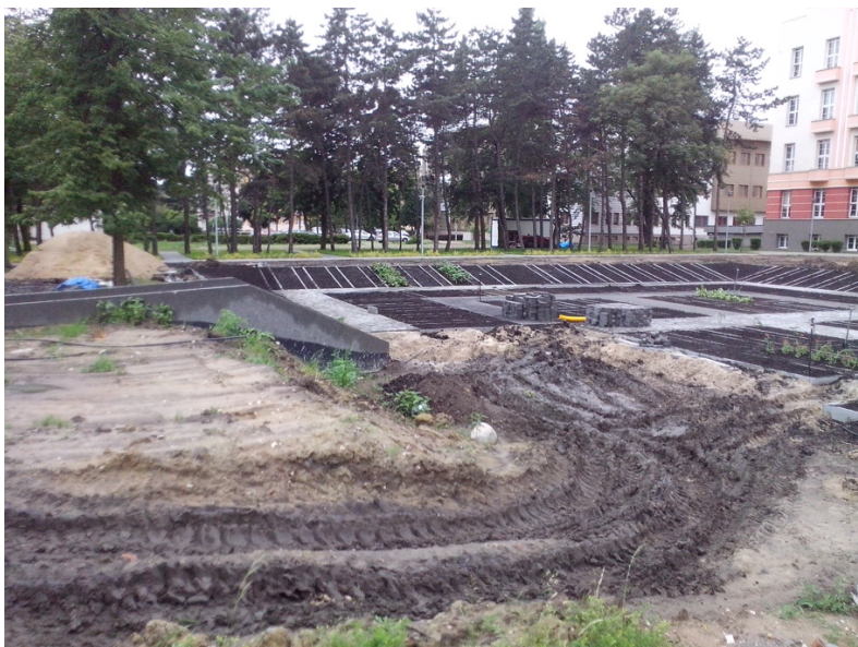
Fot. 7. Prace budowlane i instalacyjne, 28.05.2014r.
